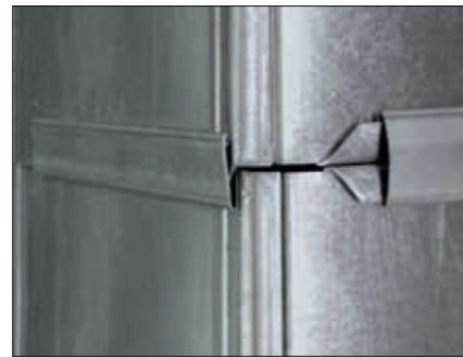
Zamek typu „S” z rolkami do listwy zamykającej (Drive Cleat)
