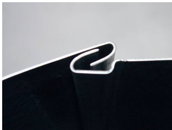
Einhängen des Langfalzes in den Umlegfalz
