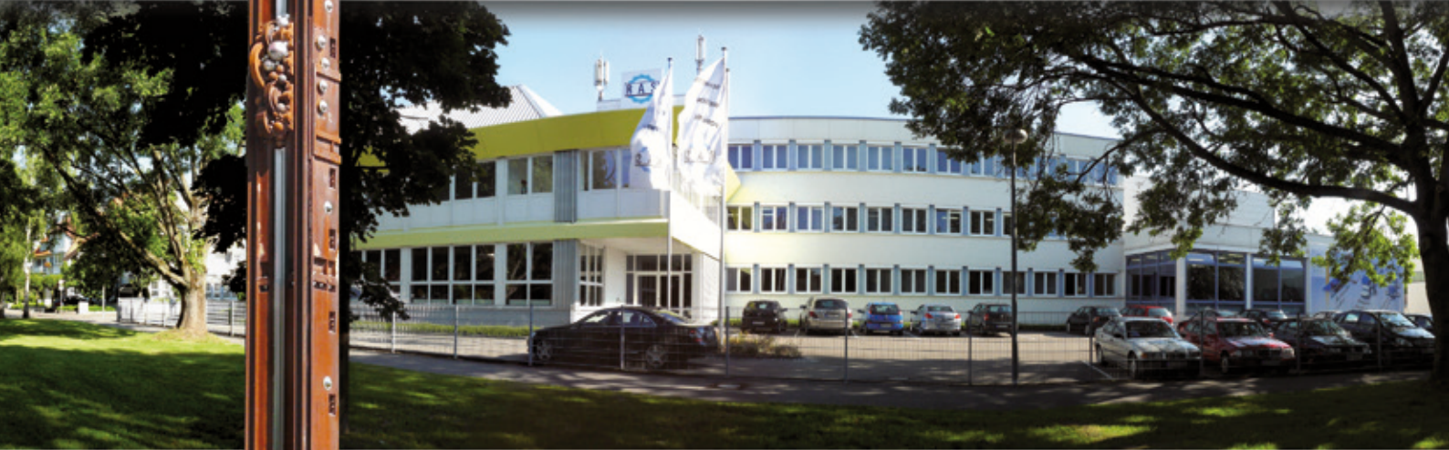
Sede centrale a Sindelfingen. All'ingresso: Opera d'arte "Stahlobjekt" di Lutz Ackermann. Hauptsitz in Sindelfingen. Im Vordergrund Kunstwerk „Stahlobjekt“ von Lutz Ackermann.
