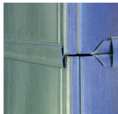
Profili a S e profilo a spinta S-Falz und Schiebefalz
